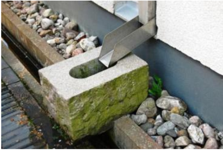
Μείωση απορροής του νερού της βροχής Ελαχιστοποίηση των πλημμύρων στην περιοχή Περιβαλλοντική και αισθητική ανάπτυξη της περιοχής
