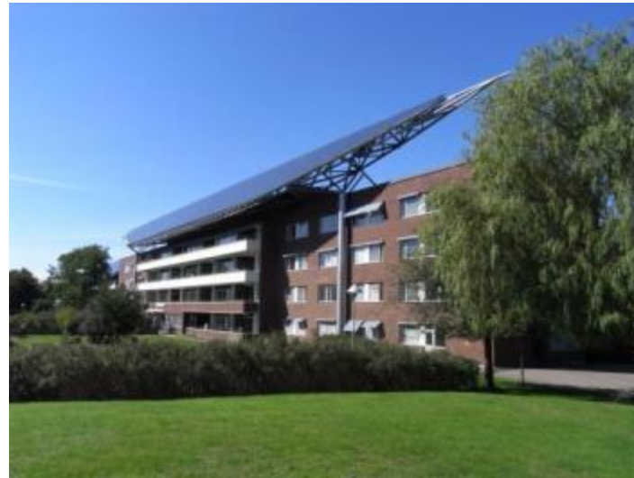
Φωτοβολταϊκό σύστημα σε υφιστάμενο κτίριο
